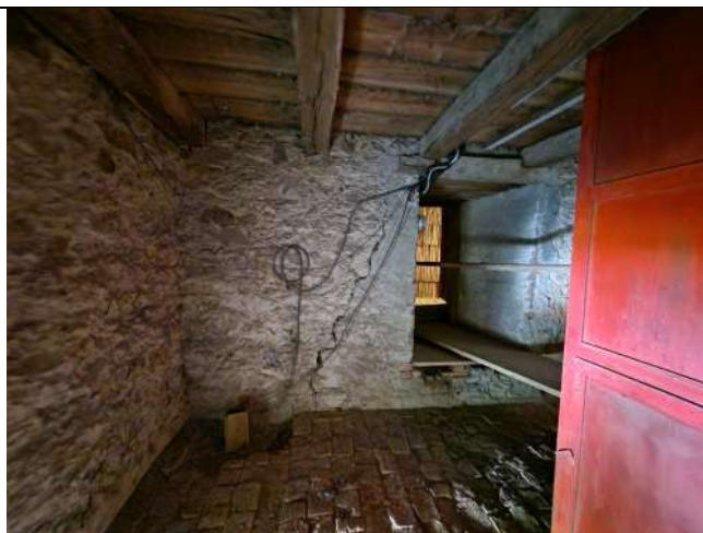
TRHLINY VE ZDIVU V ÚROVNI POD PODLAHOU HODINOVÉHO PODLAŽÍ
