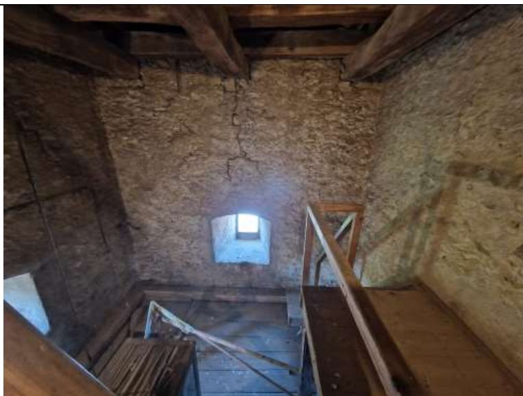
TRHLINY VE ZDIVU V ÚROVNI HODINOVÉHO PATRA
