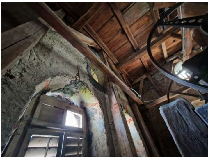
TRHLINY V ÚROVNI ZVONOVÉHO PATRA
