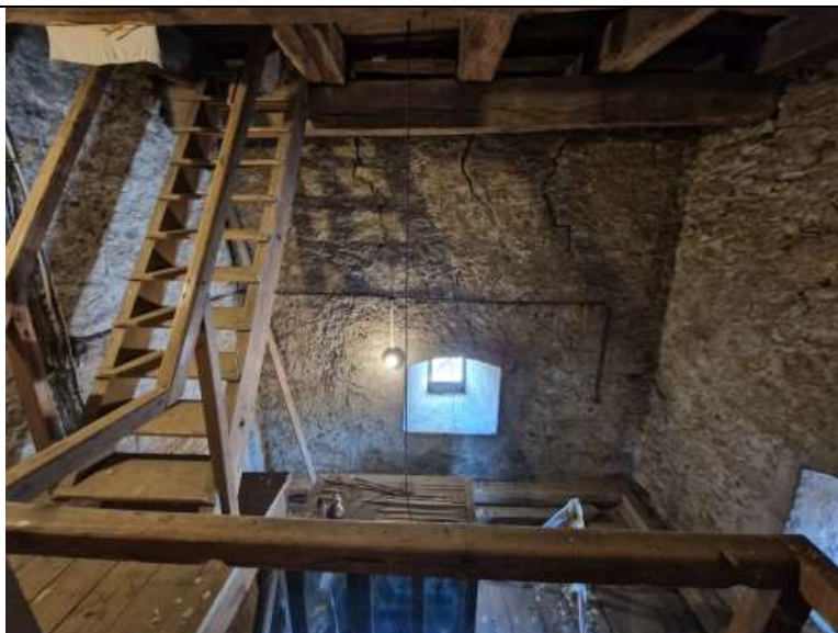
TRHLINY VE ZDIVU V ÚROVNI HODINOVÉHO PATRA
